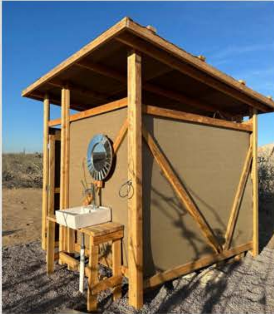
5 unidades de baños que operan con productos biodegradables, biodigestores y sistemas con ahorro de agua
